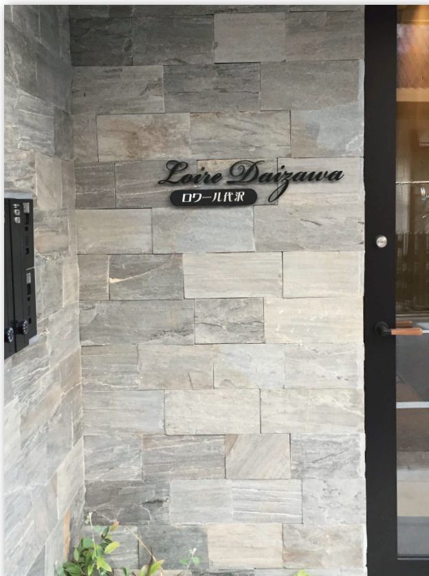
ステンレス切り文字銘板 サイズ：H≒150×W600×t5mm／加工：焼付け塗装黒 一部、エッチング
