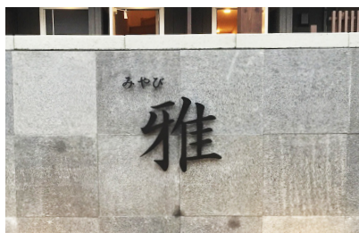
写真 No. 1481-04 品番：特注 ステンレス切り文字 納期：約 18 日 サイズ：L=300mm 加工：焼付け塗装黒
