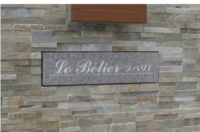
写真 No. 1477-08 品番：特注 御影石銘板 納期：約2週間 サイズ：H150×W600×D25mm 加工：文字彫り込み 色入れ
