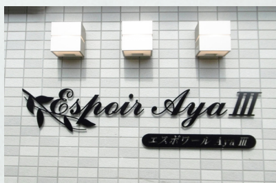
写真 No. 1420-10 品番：KSYT 切り文字銘板 ステンレス切り文字 焼付塗装黒 サイズ：L=1200 t5mm 仕 様：ボルト出し 10mm 浮かし
