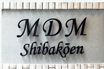
写真 No. 1420-01 品番：KSYT 切り文字銘板 ステンレス切り文字 焼付塗装黒 サイズ：L=240 t5mm 仕 様：ボルト出し 10mm 浮かし
